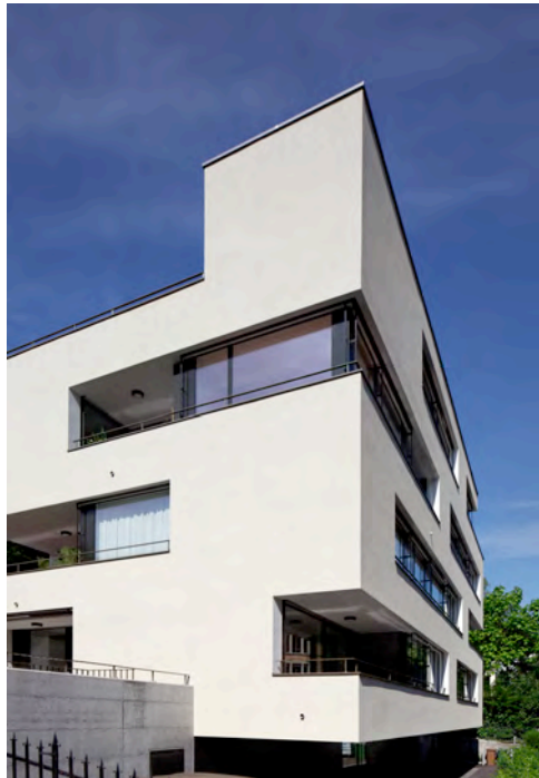
NEUBAU MEHRFAMILIENHAUS SÄLISTRASSE LUZERN
